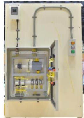
配電盤・制御盤課題
