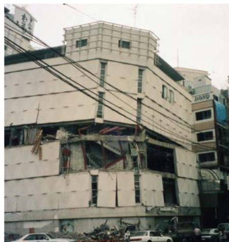
図1 崩壊した構造物（兵庫県南部地震）
