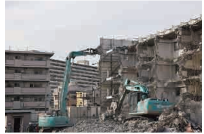
解体工事現場での調査
