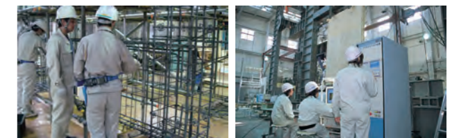
鉄筋コンクリート施工管理課題実習 木造耐力壁破壊実験
